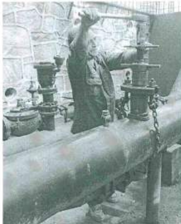
Figura 31.- Un movimiento más brusco puede llevar a remontar un hilo de rosca sobre otro
